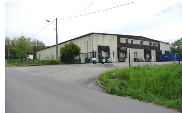
Route de la Mesalière – Revêtements de sol
