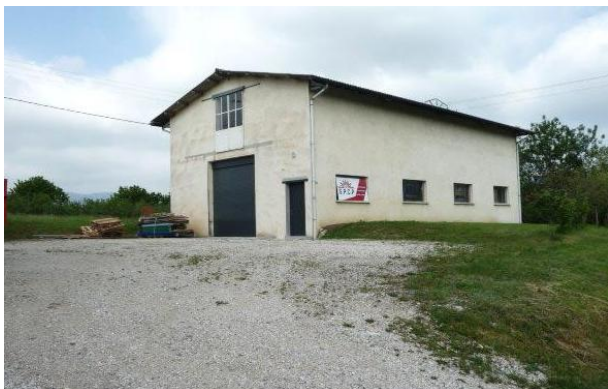
Route de la Boutique – Entreprise de construction
