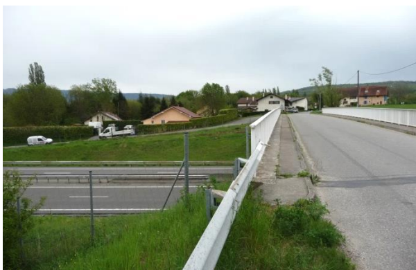
RD 239 au droit de l'autoroute A 40
