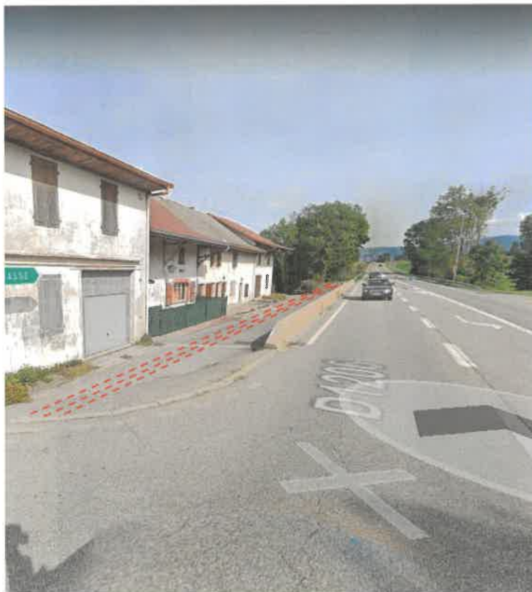
=== Pose de 3 fourreaux en PEHD 33/40
